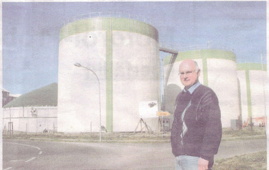
Dr. Norbert Hoogen vor der Biogasanlage.
