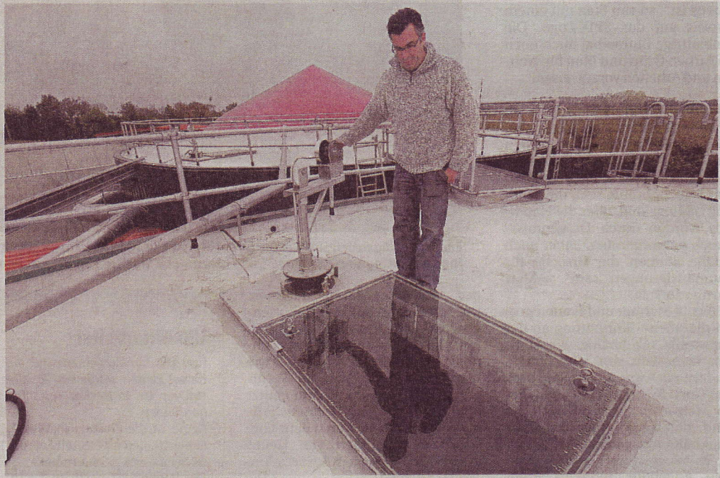
Durch ein Sichtfenster oben auf dem Dach kann Dr. Heiner Hoogen gut die Prozesse im Gasbehälter (Fermenter) kontrollieren. RP-FOTO: ARMIN FISCHER
